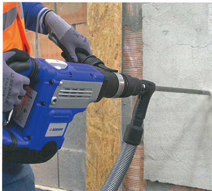
Beim Berner »CLEANdrill« sorgen vier kraftvolle Schneiden für eine einfache und präzise Führung im Bohrloch, zwei große Absauglöcher für die optimale Absaugung des entstandenen Bohrstaubs und eine aktive Kühlung des Bohrkopfes.
